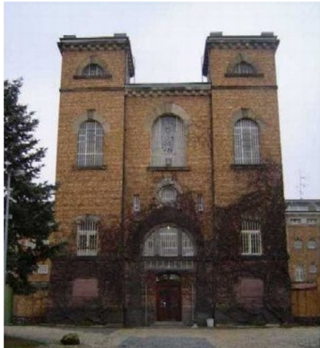
Das Portal der JVA Butzbach
